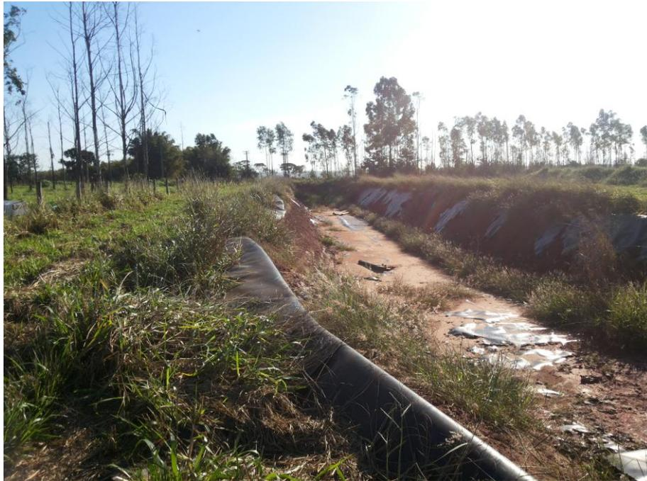
Figura 36: Manta de Pead Avariada no Aterro Sanitário
