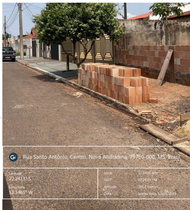
Figura 10 – Obstrução por materiais de construção – R. Santo Antônio
