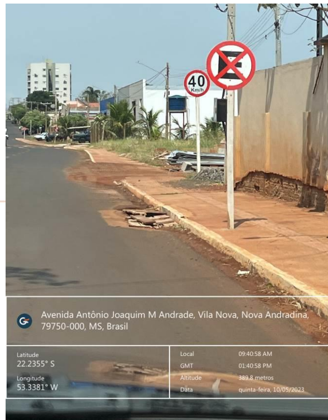
Figura 58 – Placa de 40km/h irregular (afastada do meio-fio) – R. Walter Hubacher
