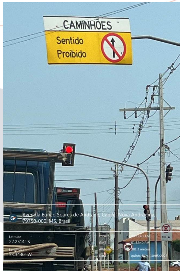
Figura 68 – Sinalização Vertical Excessiva – Av. Eurico Soares de Andrade
