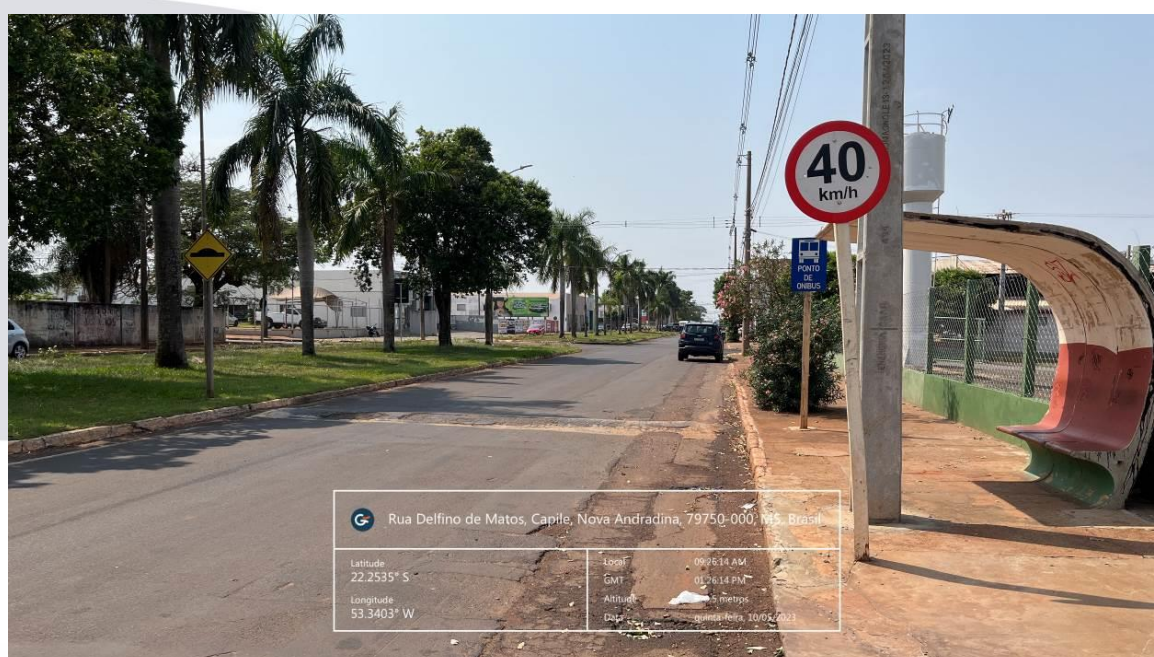
Figura 87 – Lombada irregular – Av. Eurico Soares Andrade
