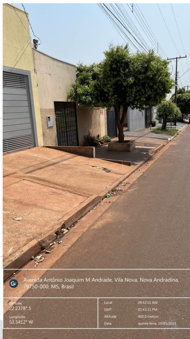
Figura 28 – Calçada sem acessibilidade – Rua Walter Hubacher
