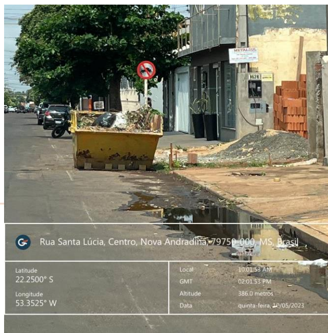
Figura 8 – Obstrução por rejeitos – R. Santa Lúcia
