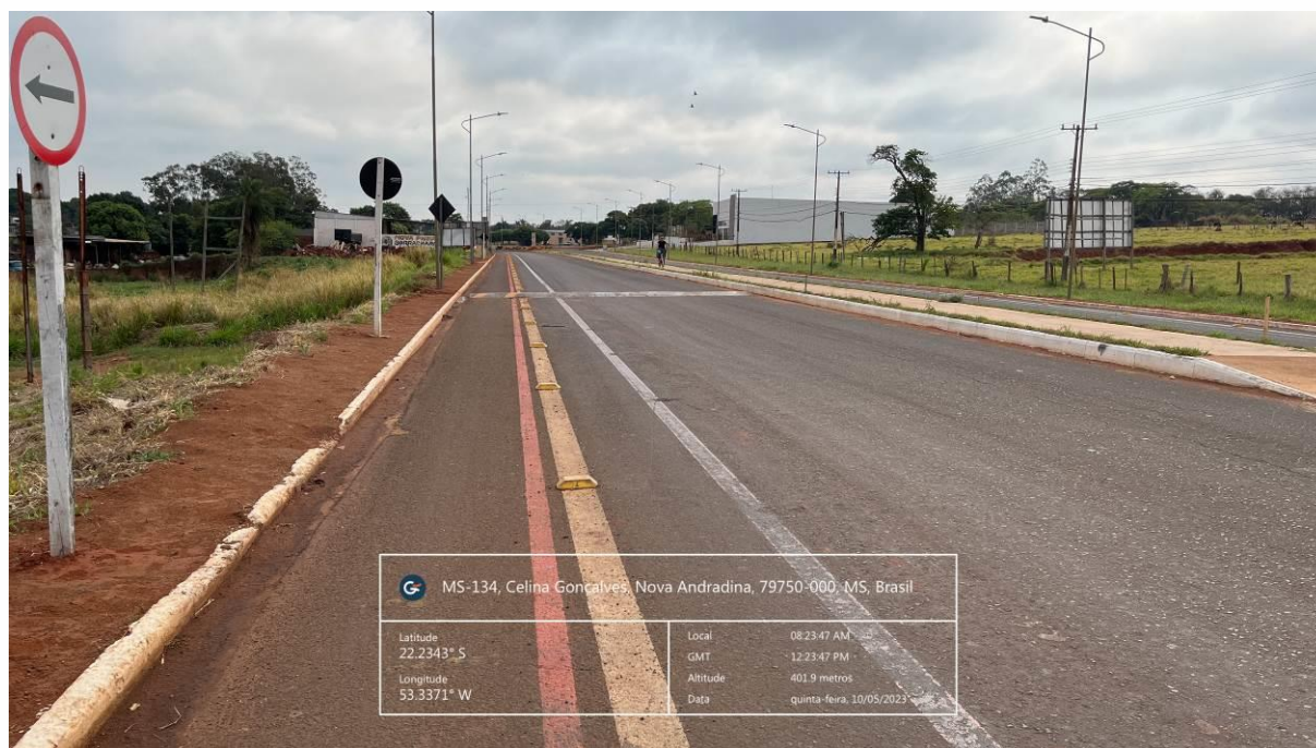
Figura 31 – Falta de calçamento em ambos os lados – Av. Antônio Joaquim de Moura Andrade.
