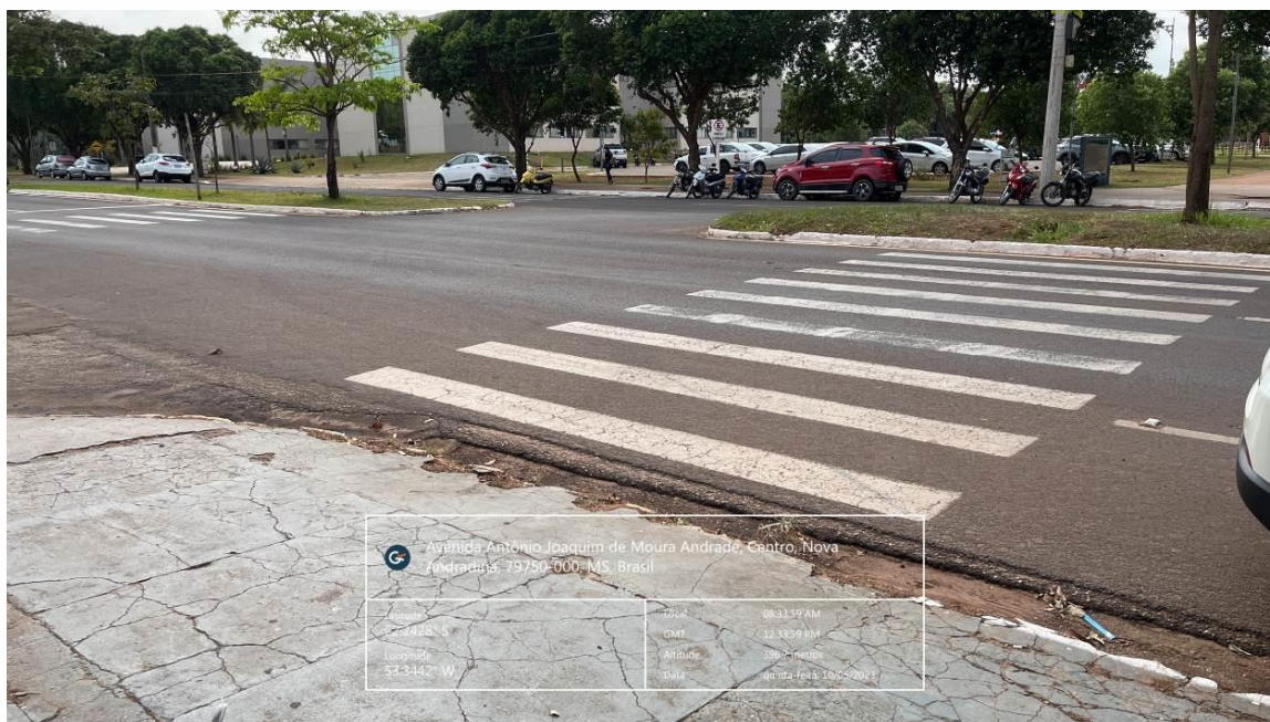
Figura 49 – Detalhamento travessia sem rampa de acessibilidade e com obstrução – R. Antônio Joaquim de Moura Andrade
